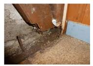
Holzkonstruktion zeigten ebenfalls im unteren Bereich schwere Schäden auf. Der mittlere Stützbalken, der den Firstbalken zu tragen hatte, hing ebenso wie die gesamte Giebelwand in der Luft. In die mit Steinwolle isolierte Wand hatten Ameisen ihre Nester bis in 1 Meter Höhe gebaut. Die Giebelwand wurde lediglich durch die Verstrebungen mit den beiden angrenzenden Wänden gehalten. Als erstes stützten wir das Dach mit Balken notdürftig ab.
